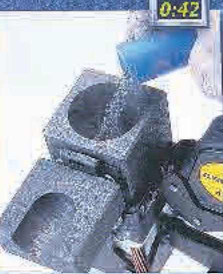
**ADIM 3** Kaynak tozu ve tüpün alt kısmına sıkıştırılmış barut pota-ya boşaltılır.
